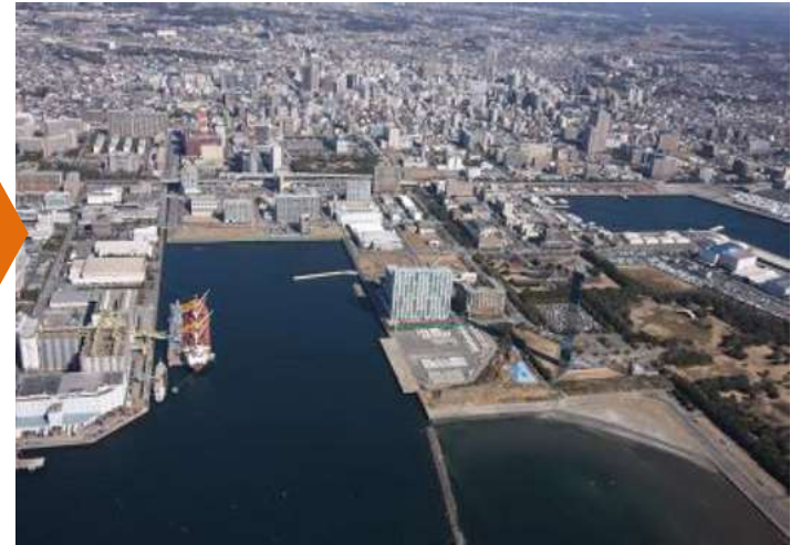
平成23年 区画整理完成後
